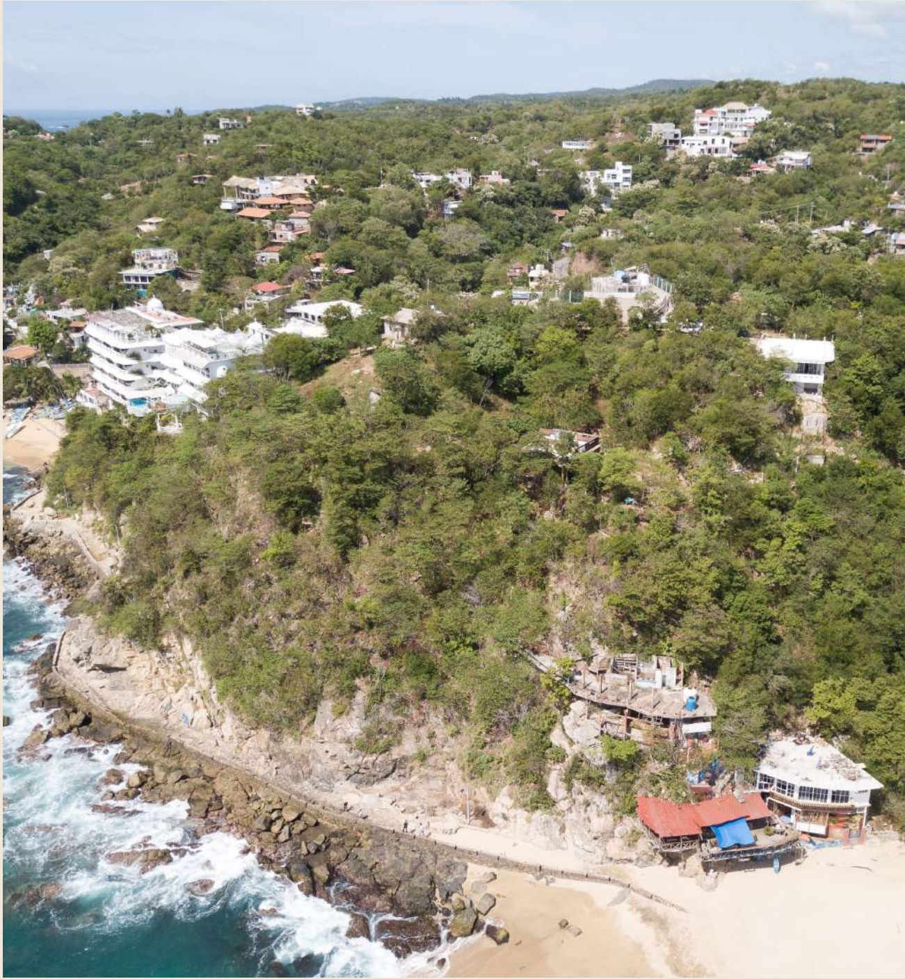
Vista Lateral del Predio
