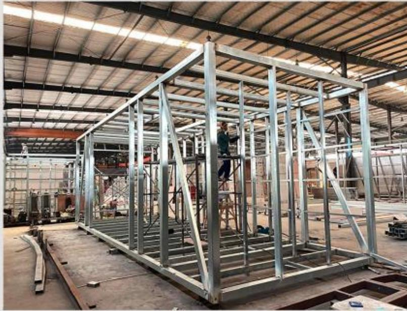
**Estructura de acero galvanizado en caliente**
